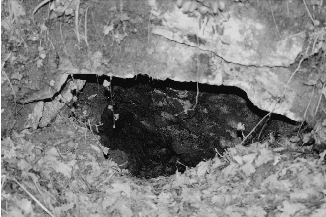
État actuel de l'entrée d'une ancienne galerie aux Allinges, à Saint-Quentin-Fallavier. Les bancs calcaires au toit de la galerie sont d'âge bajocien.
