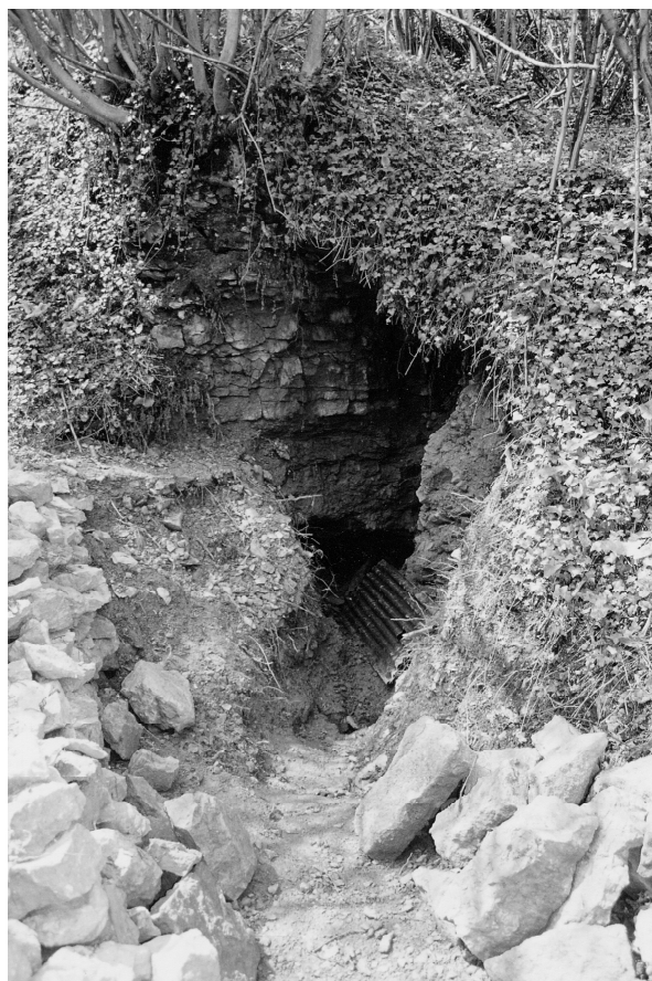
Fig. 7 - Réouverture d'une ancienne galerie de mine à La Roche.
